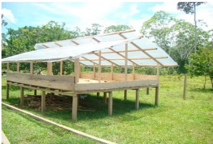
**Foto 3 – Estrutura de secagem de coco de murmurú.**
